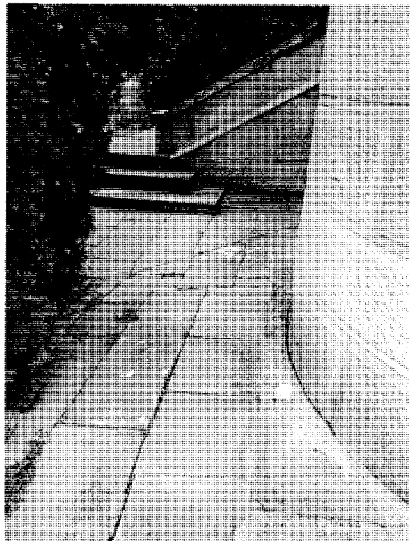
Foto 31 – Trotuar neetanș cu posibilități de pătrundere a apelor meteorice
