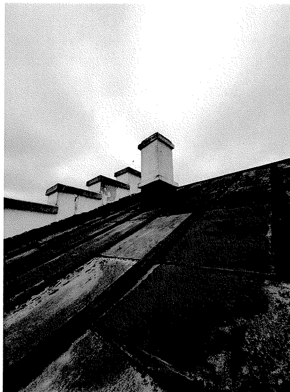
Foto 45 – Învelitoare tablă degradată
