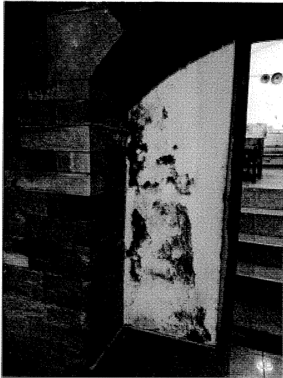
Foto 04 – Infiltrații la nivelul nivelului pereților
