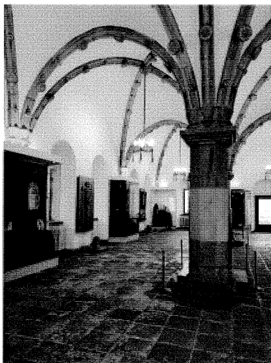
Foto 20 – Pardoseală refăcută, planșeu din beton cu placaj din piatră
