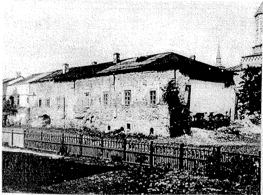
Fig. 558. Trei Ierari Iași. Sala gotică (văzută dinsore Sud) înainte de restaurare
