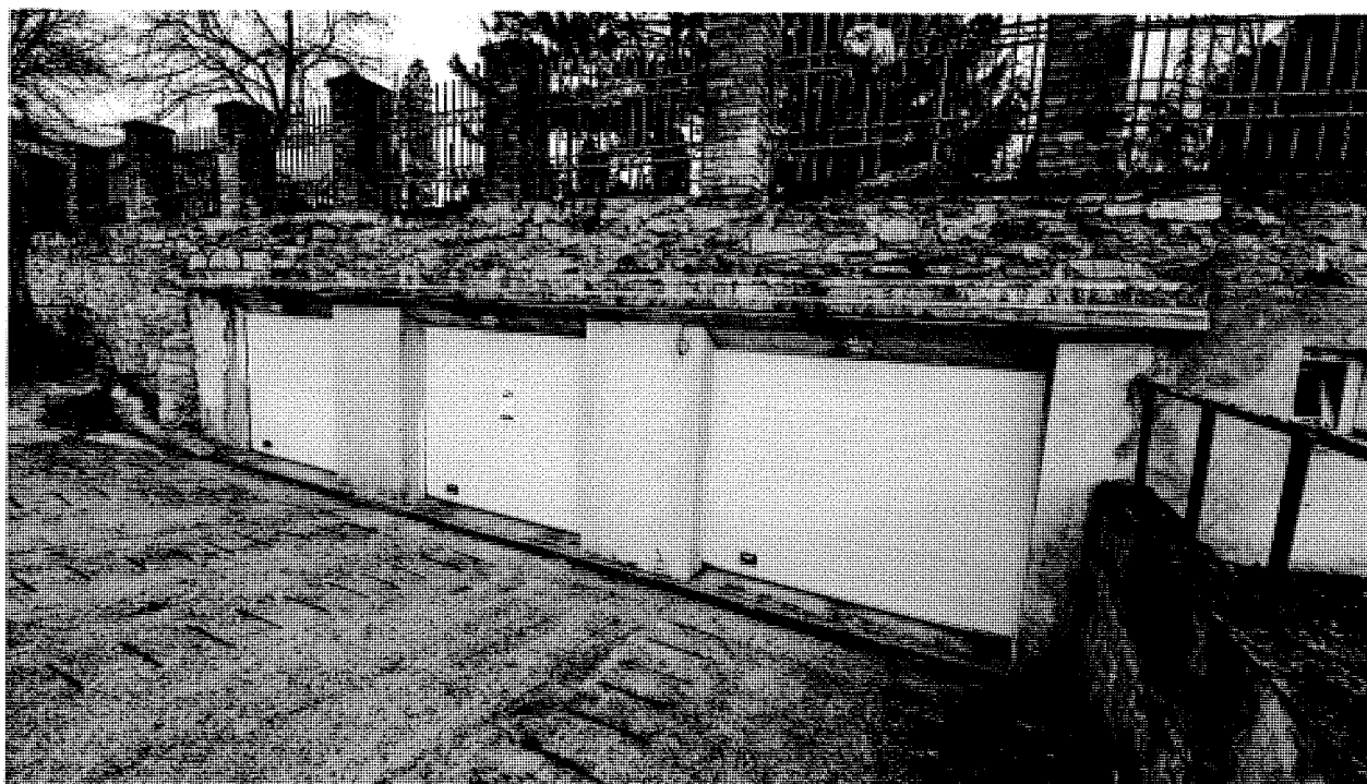
Foto 60 – Garaje subterane executate prin dezafectarea zidului de sprijin
