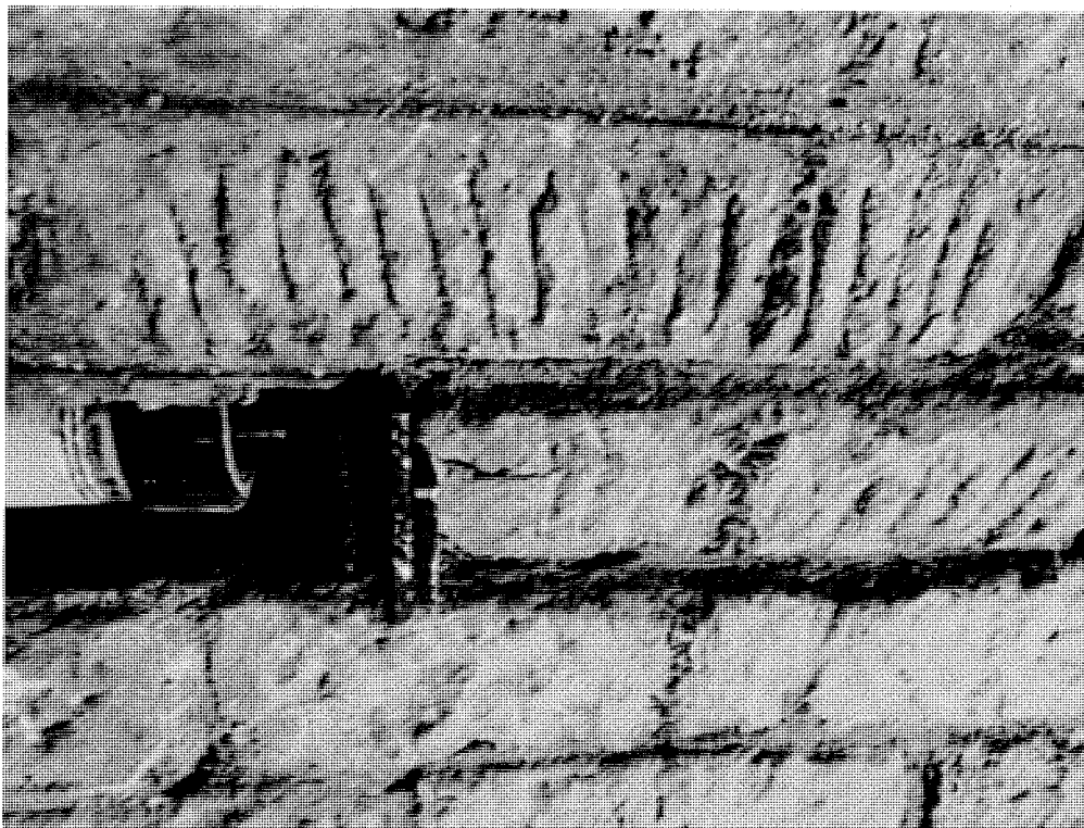
13 ).TEST FORFECARE PRESA POZ 2 MORTAR -PRESA 10 t SUBSOL 2 SUBSTRAT UMED SATURAT
