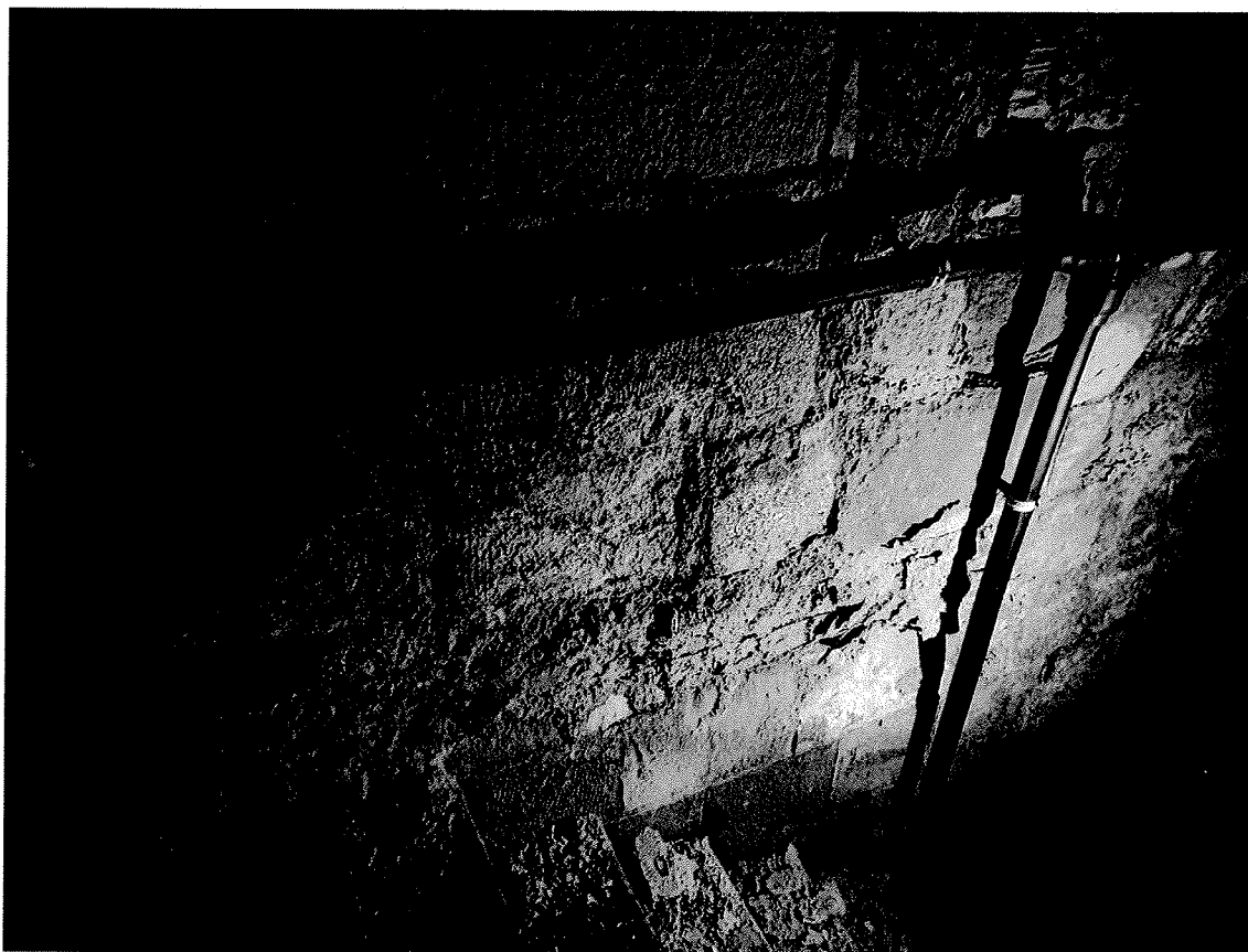
Foto 03 – Descompuneri ale zidăriei din piatră și expulzare cauzată de fenomenul de absorbție capilară
